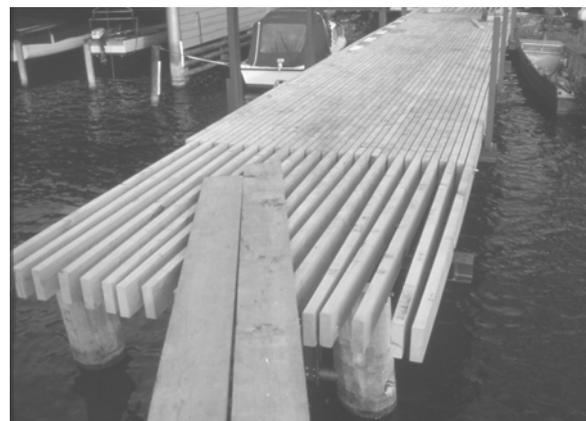
Montagestoss, durchlaufender Trägerrost
