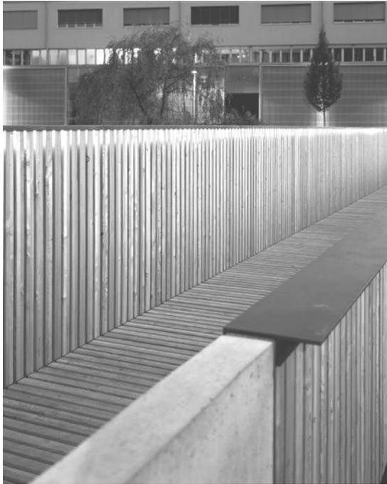
Die Beleuchtung, ein Lichtband, ist im oberen Geländer eingebaut
