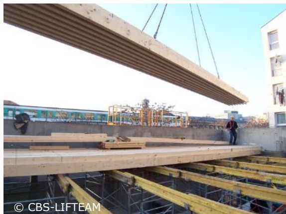
Illustration 3 : Mise en œuvre D-dalle®
