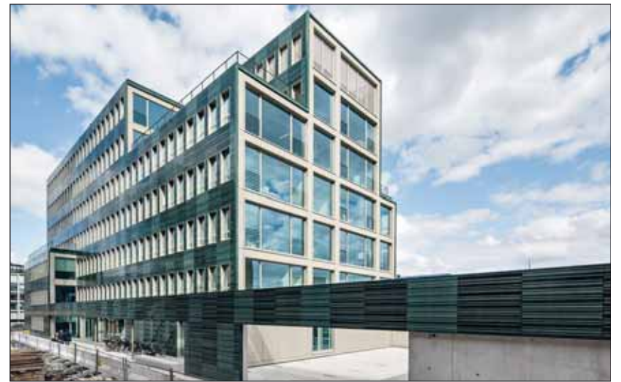
Das 25 m hohe H7 in Münster mit einer Fassade aus Glas und grün glasierten Keramikelementen ist derzeit das höchste Gebäude in Holz-Hybridbauweise in Nordrhein-Westfalen. Es besteht hauptsächlich aus vorgefertigten Holz- und Holz-Beton-Verbund-Bauteilen. Foto: Heupel Architekten
