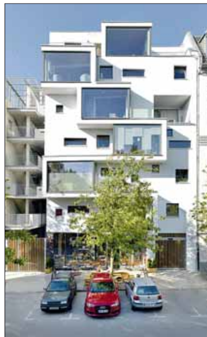
Das C13 in Berlin ist ein Skelettbau mit Unterzug-Stützenkonstruktion und nichttragenden Außenwänden sowohl in Rahmenbauweise als auch in BSP-Bauweise. Foto: Bernd Borchardt, Kaden Klingbeil Architekten
