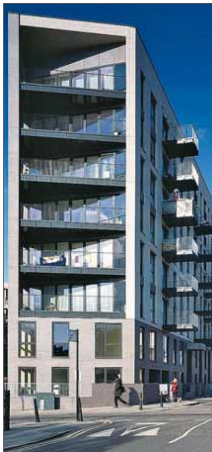
Das achtgeschossige Mehrfamilienhaus Bridport Place in London wurde aus Brettsperrholz errichtet. In Skelett-/Rahmenbauweise wäre der Holzverbrauch nur ein Drittel so hoch ausgefallen. Foto: Ioana Marinescu
