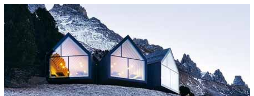
Die drei Panoramafenster stellen den Bezug zur tradierten Form von Häusern mit Satteldach her und erschließen sich dem Betrachter sofort. Darin liegt auch die Originalität des Entwurfs, Altbekanntes in eine neue Form zu übersetzen.
