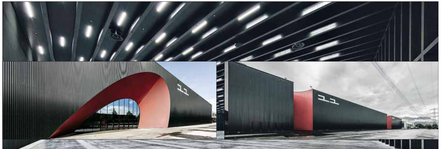
Nach Fertigstellung der Messehalle Dornbirn (Österreich) wurde das Holztragwerk schwarz gestrichen. Von den Fachwerkträgern sind schließlich nur noch die Untergründe zu sehen. Die Bereiche dazwischen nutzten die Planer zur Platzierung der Beleuchtung. Auch in der Außenansicht dominiert schwarz, unterbrochen durch rote Akzente im Bereich des ungewöhnlich ausgeformten Haupteingangs (links) bzw. den Seiteneingängen (rechts). Fotos: Faruk Pinjo (4)
