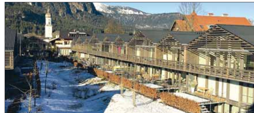
Das neue „Wohnquartier Gapa“ nahe des historischen Zentrums von Garmisch ist ein Baugruppen-Projekt. Es besteht aus zwei Häuserreihen in Holzmassivbauweise mit flach geneigten Satteldächern und giebelseitigen Loggien unter großen Dachüberständen. Foto: S. Jacob-Freitag
