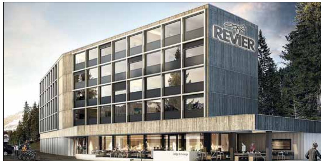
Das Hotel Revier in der Lenzerheide (Schweiz) beherbergt 96 Zimmern. Das lange, schmale Gebäude steht an der steilen Geländekante des mächtigen Bergwalds im Hintergrund und folgt mit zwei leichten Knicken der Uferlinie des Heidsees. Auf Basis schmaler Module in Brettsperrholz-Massivbauweise kam es mit nur vier Geschossen auf einem Sockelgeschoss aus.
