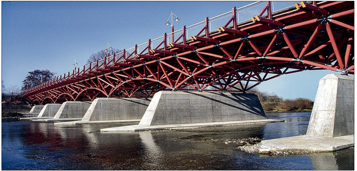
Die von Richard J. Dietrich geplante Holzbrücke über die Isar in München-Thalkirchen.
